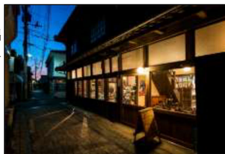
三津浜のリノベーション古民家
